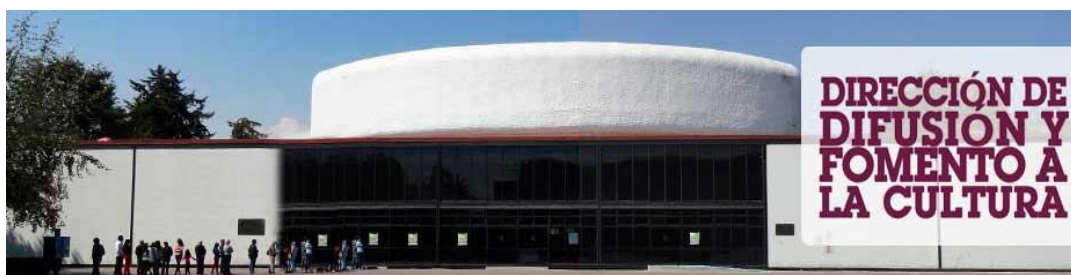
Fig. 14. Auditorio Ing. Alejo Peralta. Auditorio principal del Centro Cultural Jaime Torres Bodet
